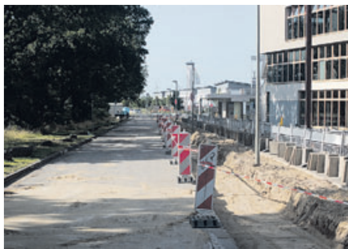
Die Straße Am Johannisland wird zurzeit auf eine Breite von sechs Metern ausgebaut. Foto: mk
