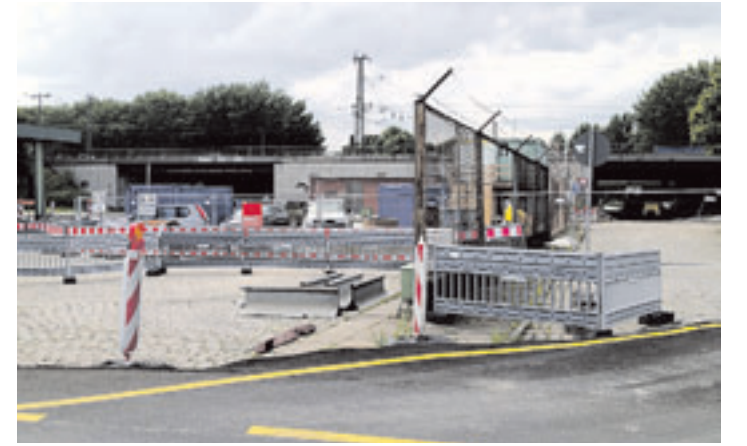
Hier wird schon gebaut: Der Hafenverkehr umfährt demnächst die Veddel und fließt parallel zum Bahndamm Richtung Norden auf die Elbbrücken. Fotos: ten
