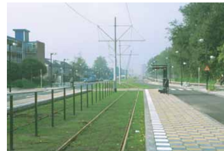
6 Hoofdweg naar de Aker: tram in middenberm, vrijliggende fietspaden, nieuwe aanplant bomen
