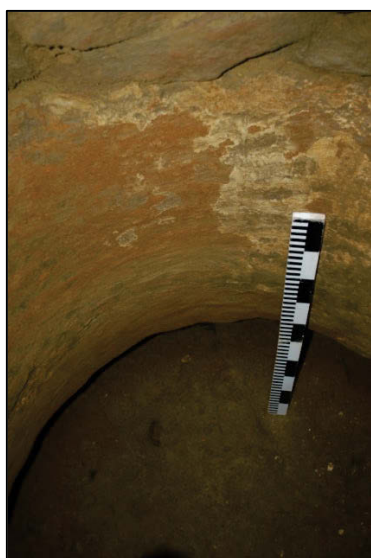
FIG. 20 Kalkaanslag op de ijzerzandsteenlaag.
