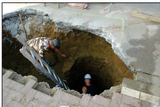
FIG. 14 Het opschonen van de werkput.
