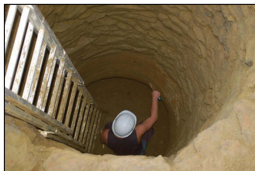
FIG. 15 Het opschonen van de waterputschacht.
