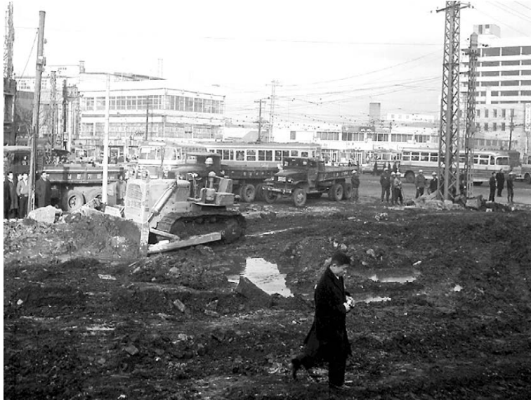
14 | Construction work, 1966 (© 서울 시립대학교 & 서울특별시)
