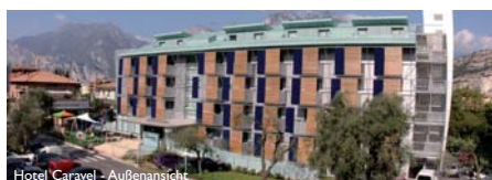
Hotel Caravel - Außenansicht
