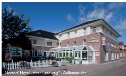
Nortorf, Hotel „Alter Landkrug“ - Außenansicht
